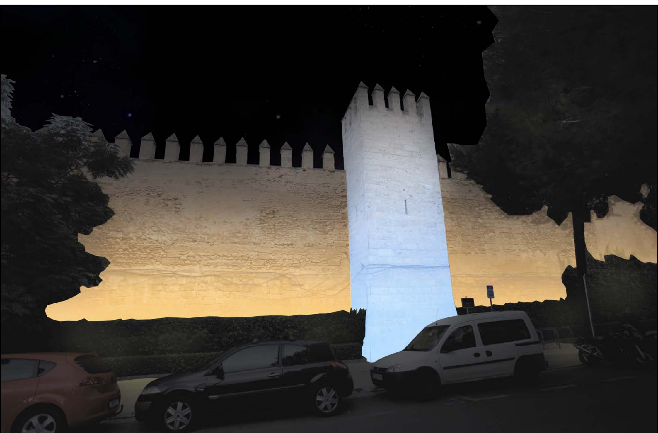
MURALLA MEDIAVAL DEL CONVENT DE SANT GERONI
