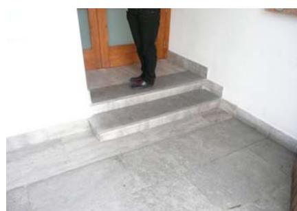
Graons a l'entrada del centre
