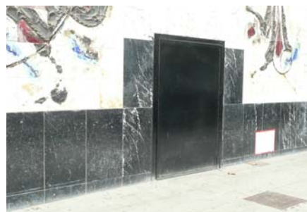
Accés per a PMR (exterior)
