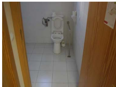
Cabina adaptada a la UIAP
