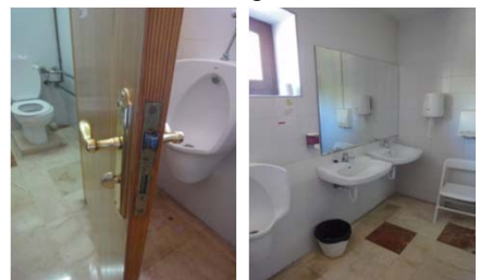
Interior del servei higiènic d'homes
