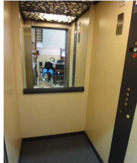
Interior de la cabina
