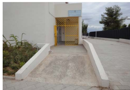
Rampa i reixa d'accés a l'edifici
