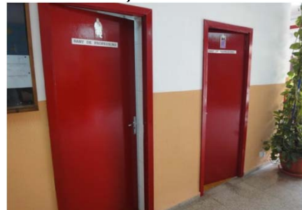
Interior del col·legi (zona de banys)
