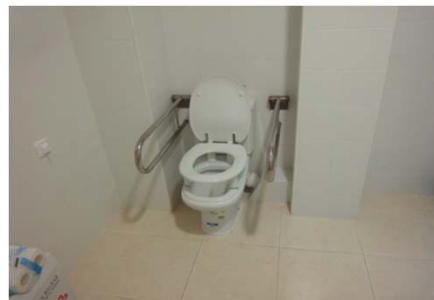
Interior bany adaptat amb barres auxiliars
