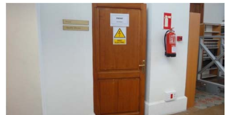
Porta sala de màquines
