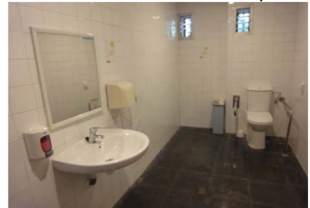
Interior del servei adaptat per dones
