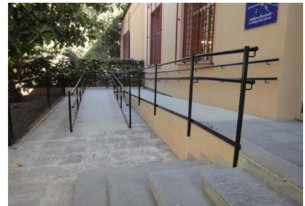
Rampa i escala d'accés a l'edifici
