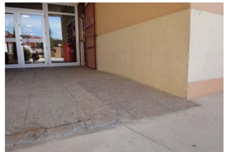
Rampa i esglaó d'accés
