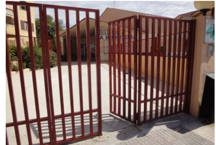
Portes d'accés al recinte
