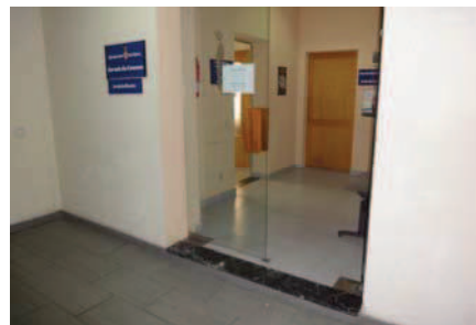
Accés zona d'escala i oficines
