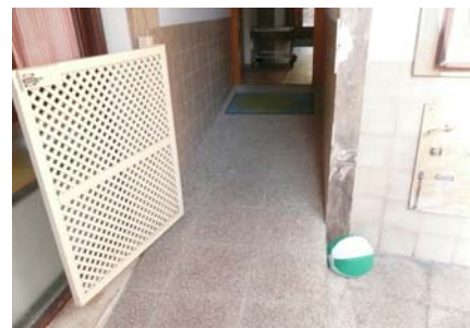
Rampa accés pati
