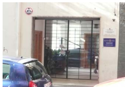
Accés al centre
