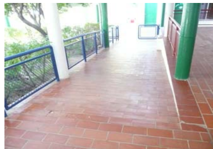
Rampa entre els dos nivells
