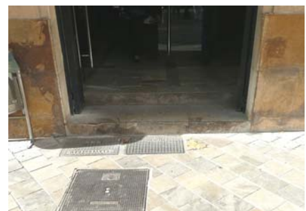
Accés a la zona Atenció al ciutadà (principal)
