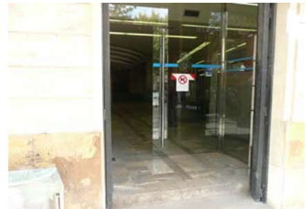
Accés a la zona Atenció al ciutadà (principal)
