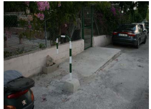
Rampa d'accés amb obstacle
