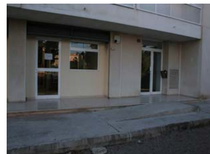
Local i rampa d'accés
