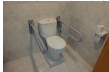
Interior bany adaptat amb barres auxiliars
