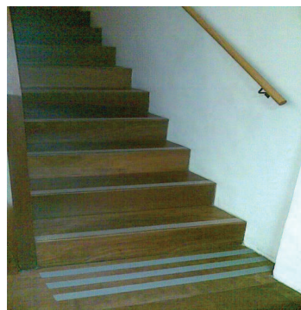
Detall de senyalització de l'escala
